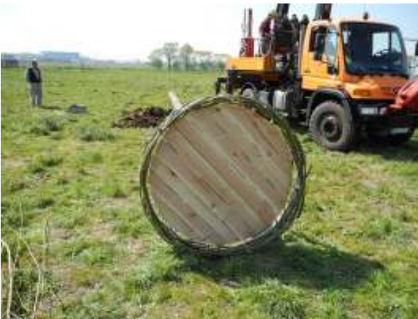
Ein Holzboden wurde in den Metallkranz eingebaut
