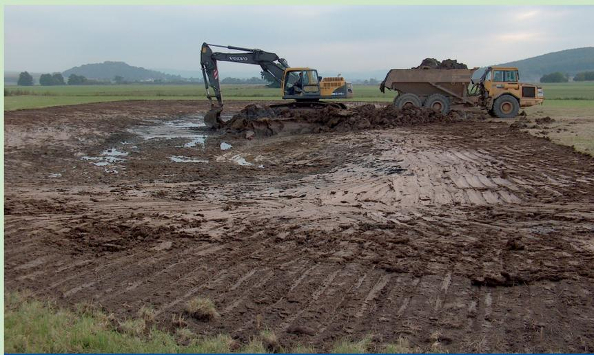
Hier rücken die Bagger für den Naturschutz an: Flache Flutmulden werden ausgehoben, die sich schon nach kurzer Zeit mit Wasser befüllen.
